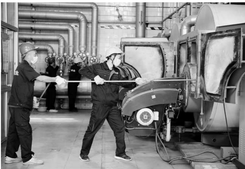
维修师傅在锅炉房内对供暖设备进行夏季检修。
