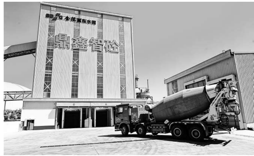
智慧商砼站投运现场。 ■企业/供图
