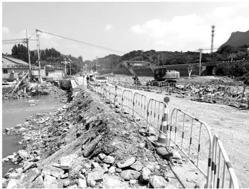
密兴旧路山区公路修复现场。 ■企业/供图
