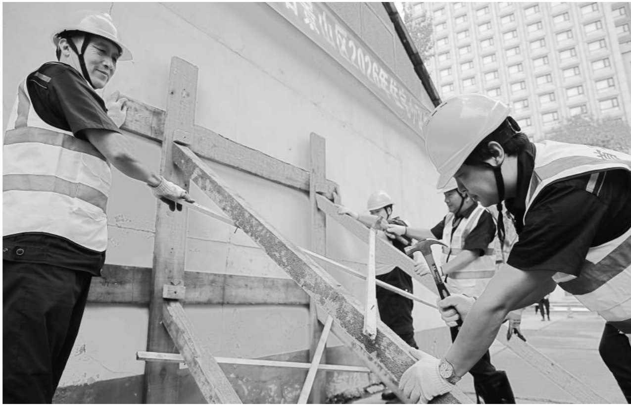
抢险人员正对隐患墙体实施应急支护。
