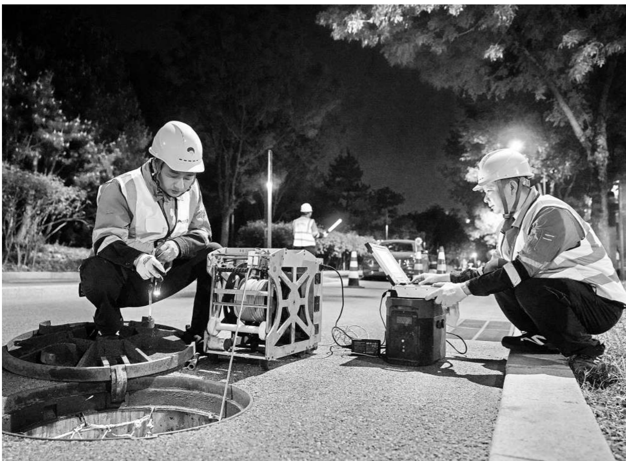
排水集团“清管行动”现场。
