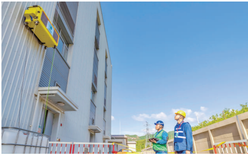
延庆换流站作业人员应用外墙清洗机清洁阀厅外墙。 通讯员 张笑谭摄
