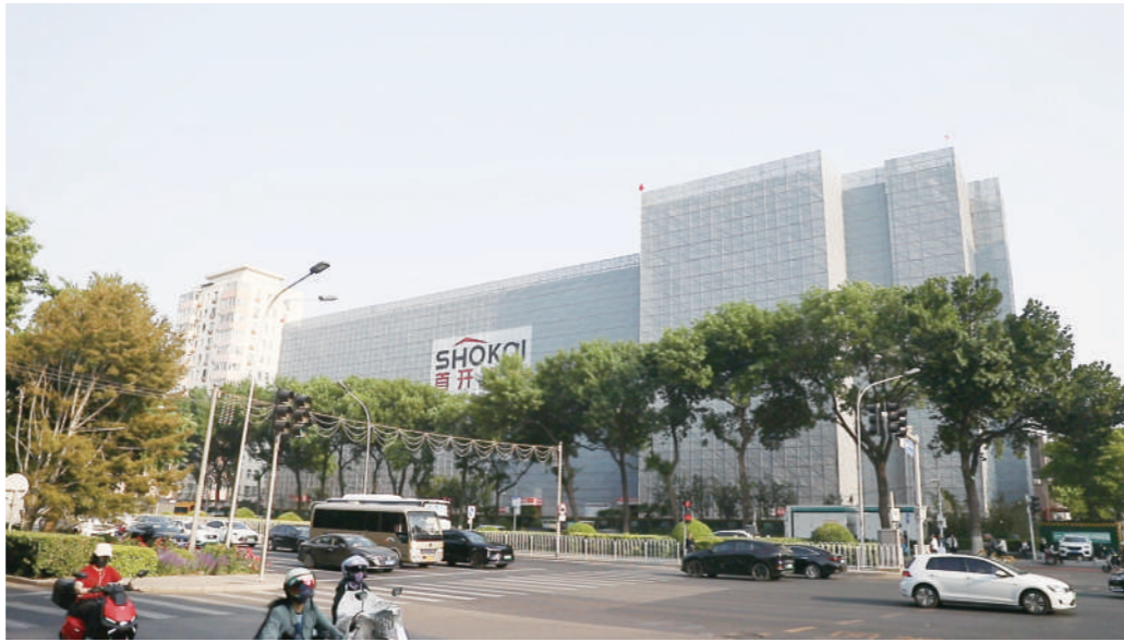
前门东大街8号楼旧改工程现场。
