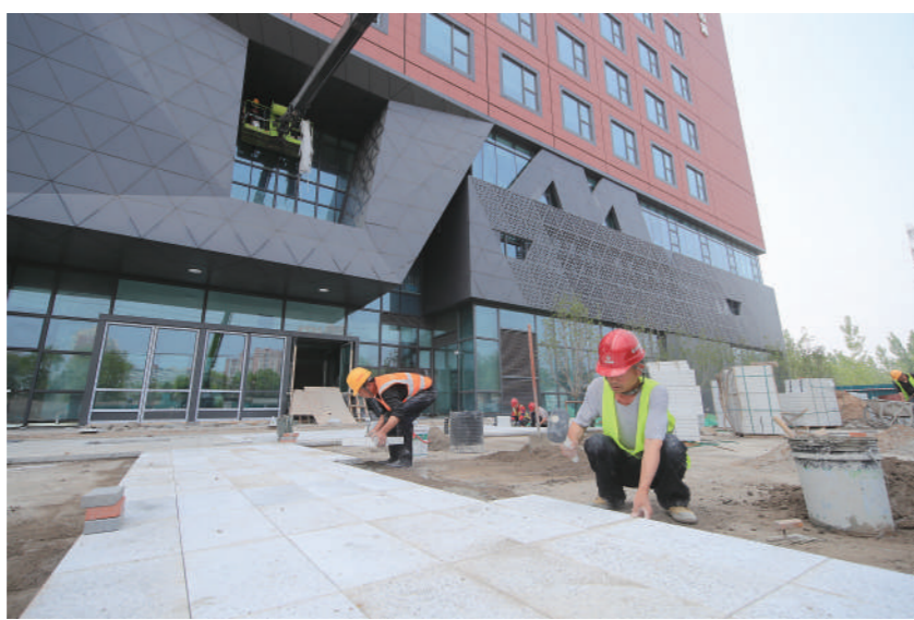
施工人员正在进行室外铺装作业。
