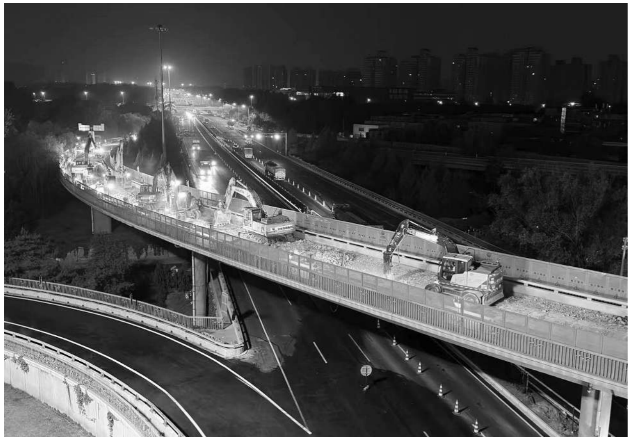
东北四环“咽喉要塞”四元桥区现场。
