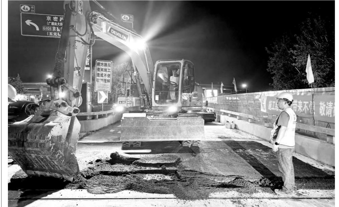
四元立交桥系桥面混凝土铺装翻建施工现场。
