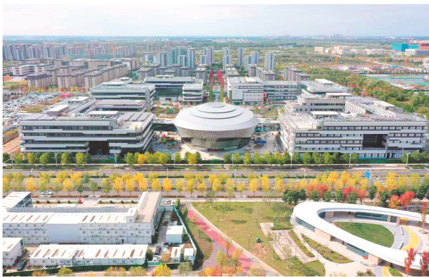
国家电网能源互联网产业雄安创新中心外景。
