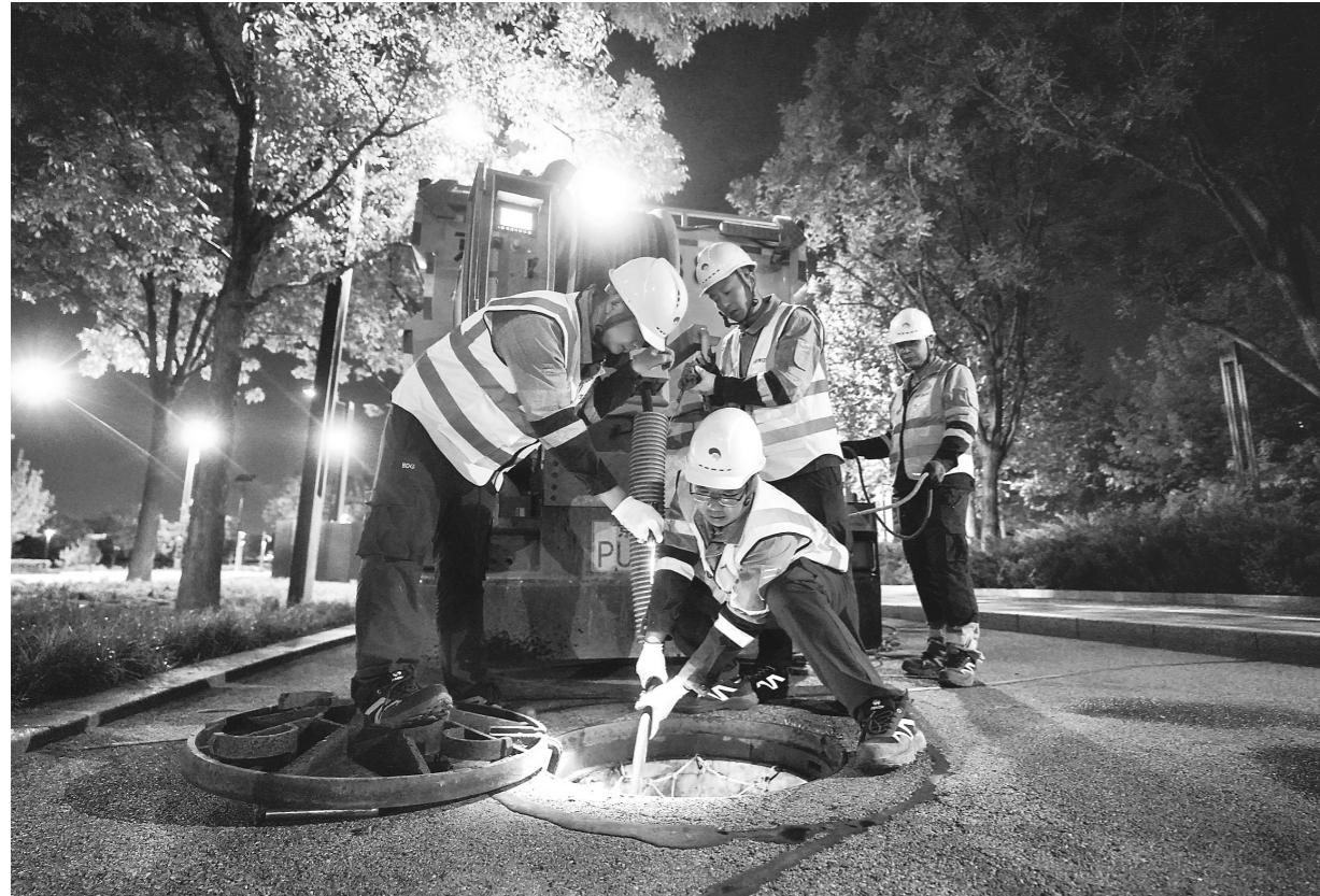
北京排水集团2026年度“清管行动”现场。
