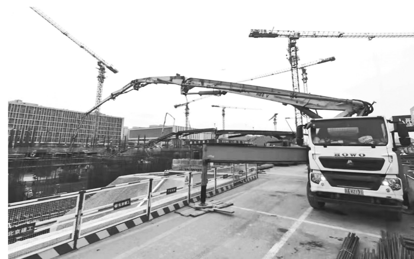
北京鲜活农产品流通中心二期项目现场。
