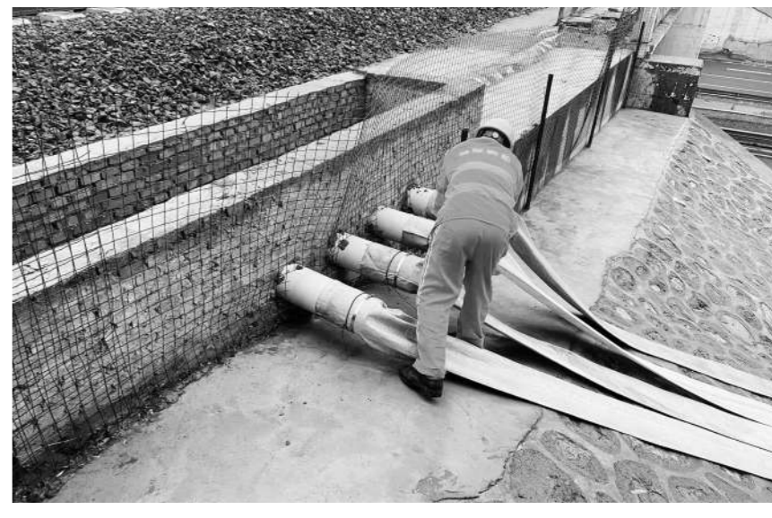
工作人员正在加密重点地段巡查。
