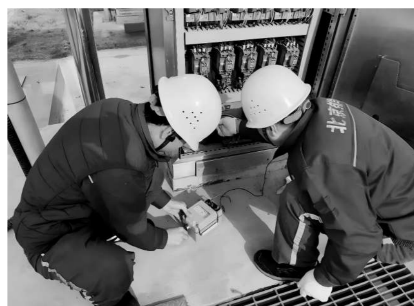
工作人员正对泵站设备进行维护。
