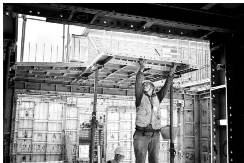
工人正在安装铝模构件。
