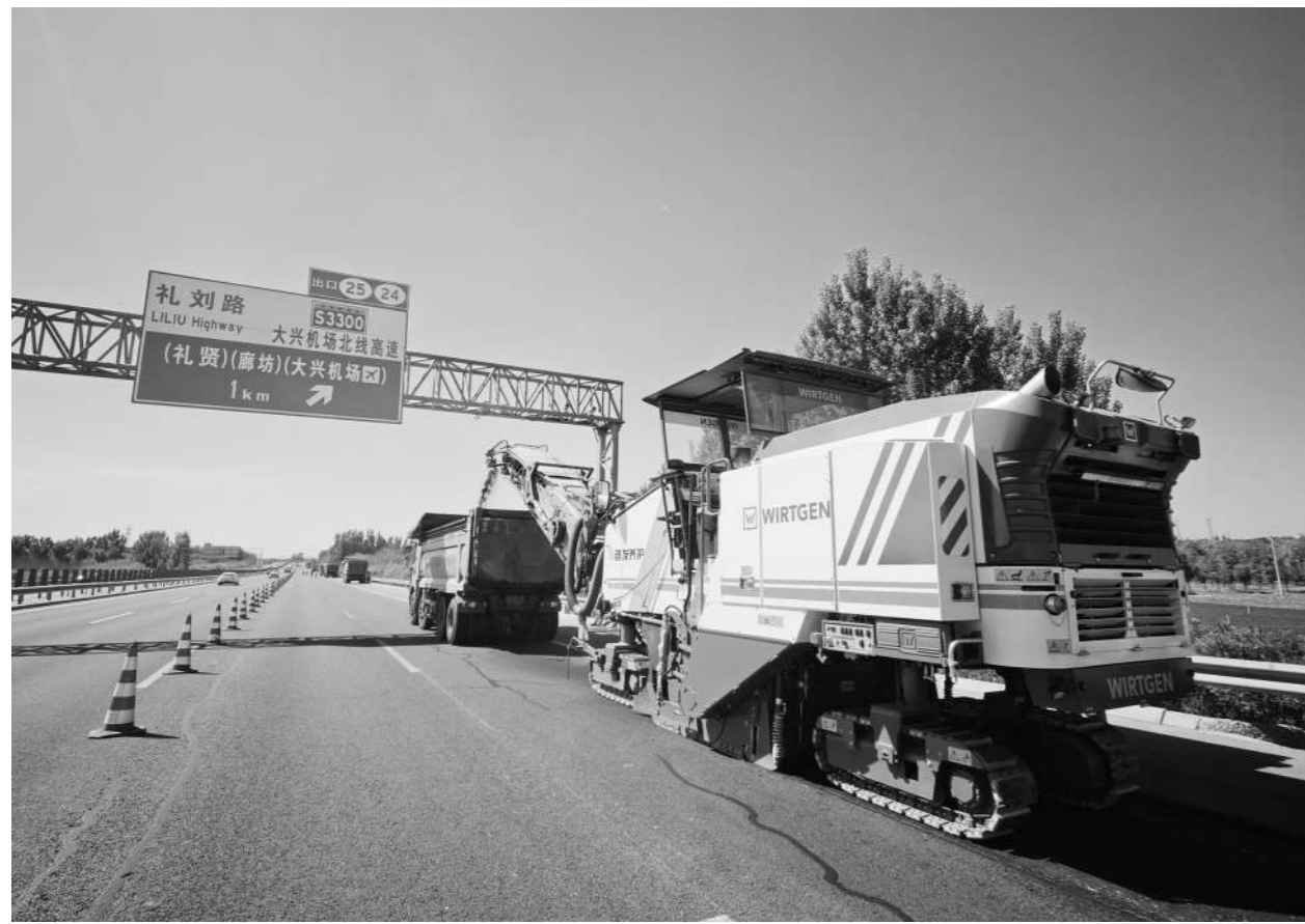
高速路养护工程现场。
