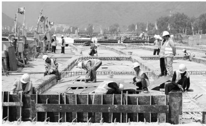
国道108三期道路工程(门头沟段)在紧张施工中。
