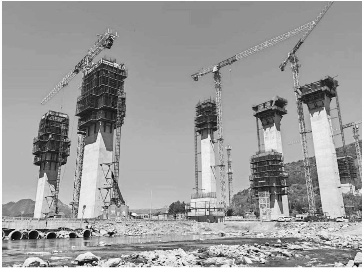
108新线高速公路工程全力冲刺节点目标。
