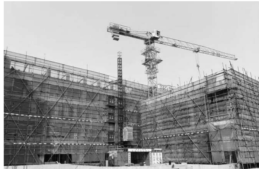
城市副中心抢修调度指挥中心项目现场。
