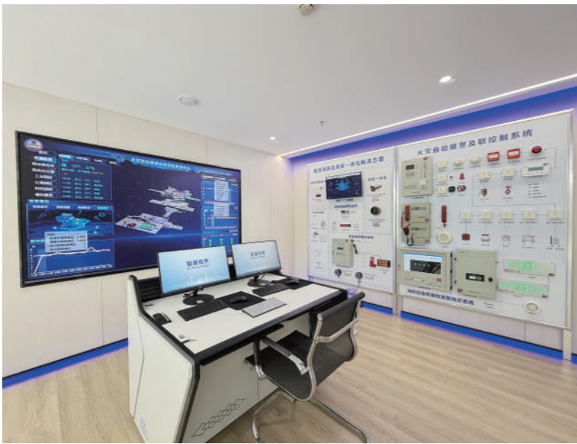
智慧展厅大屏实时监控北京西站基础设施。
