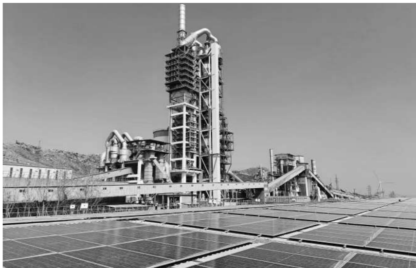
项目利用屋顶光伏板盘活闲置资源。
