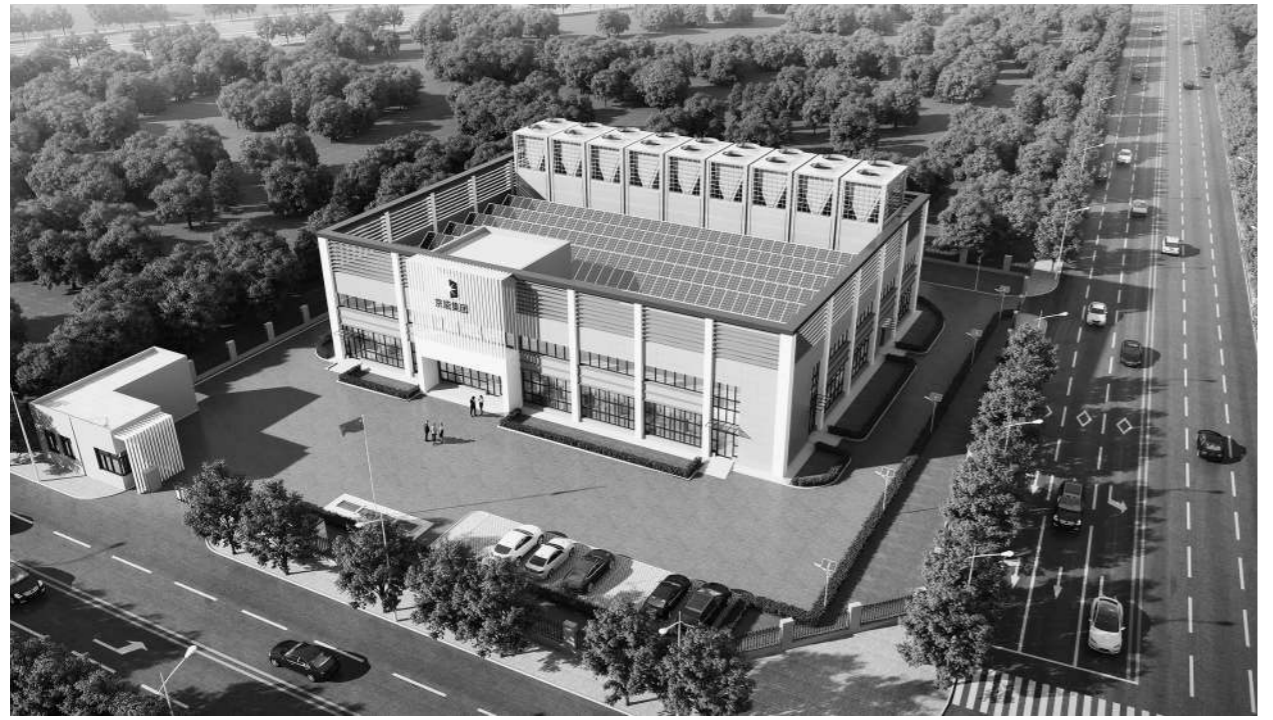
门头沟中关村人工智能科技园能源中心项目。
