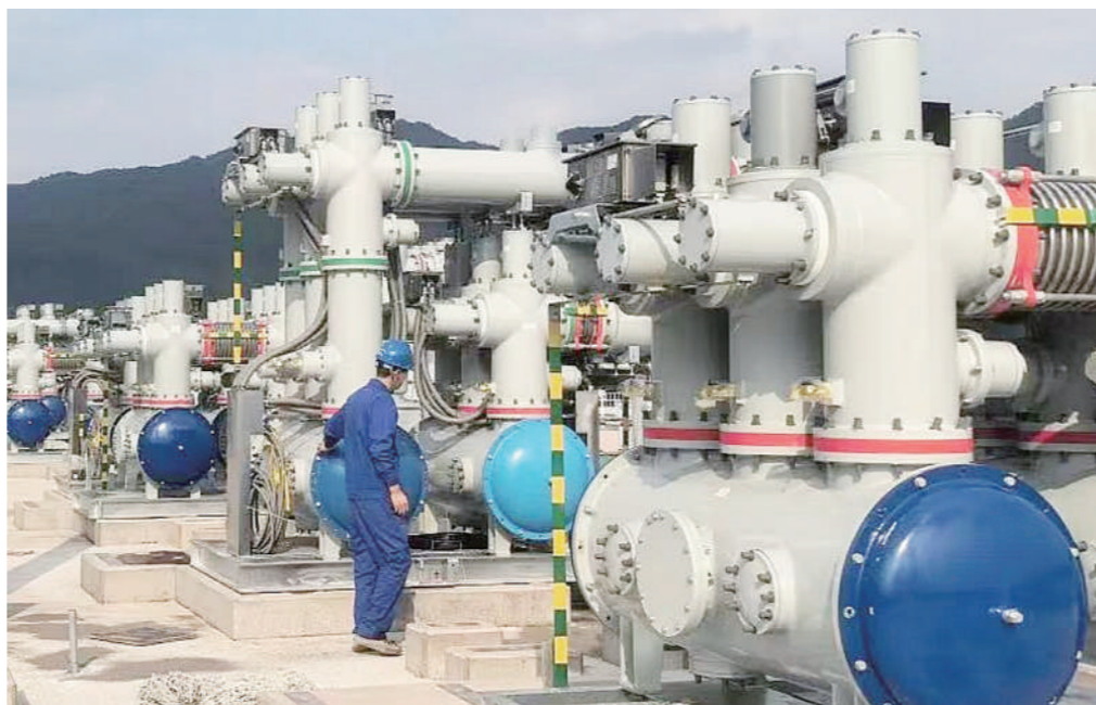
为汀州(龙西)变电站新建工程供货的ZF19-252型气体绝缘金属封闭开关设备(GIS)已顺利完成生产并交付。 ■企业/供图
