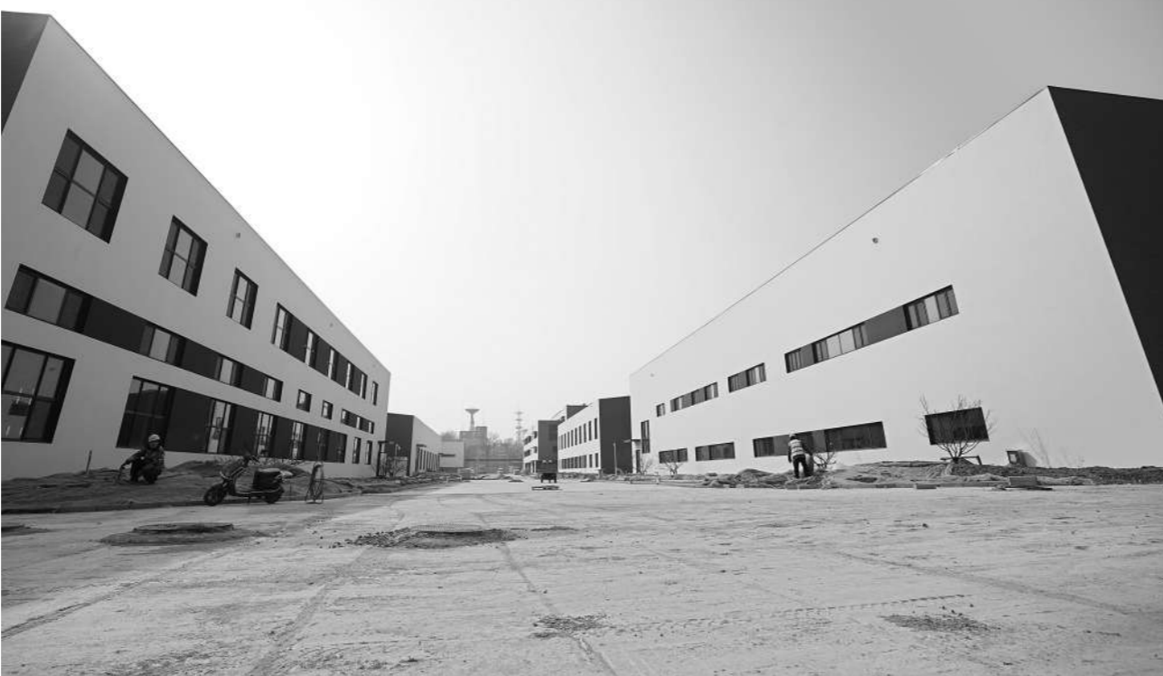
金隅生命科学创新中心项目。
