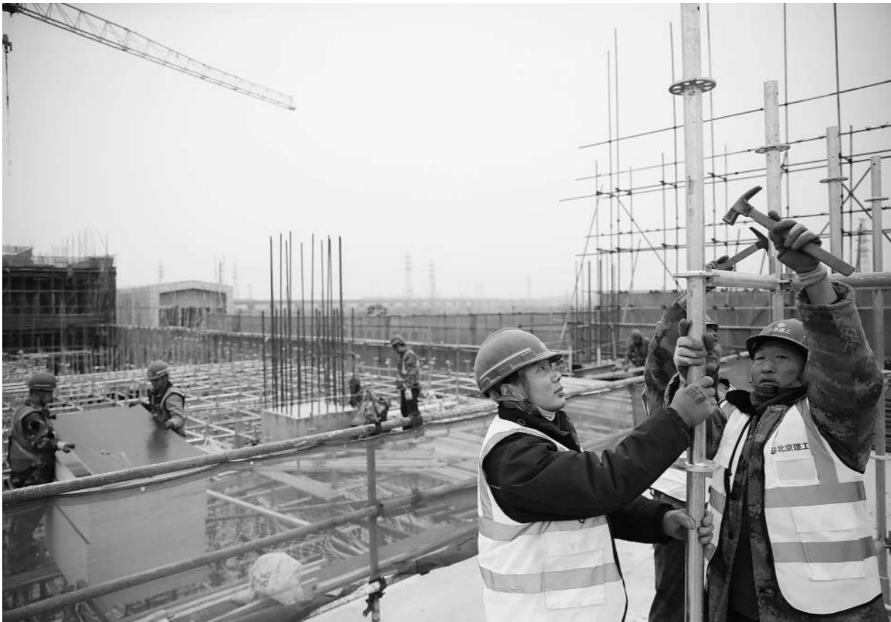
工人正在安装脚手架。 ■记者 董一鸣/摄
