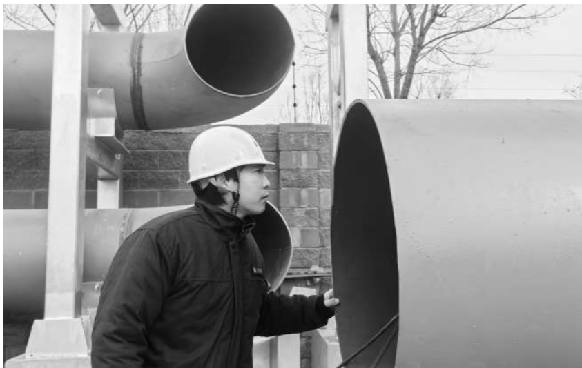
赵凯春节期间驻守施工现场进行设备检查。
