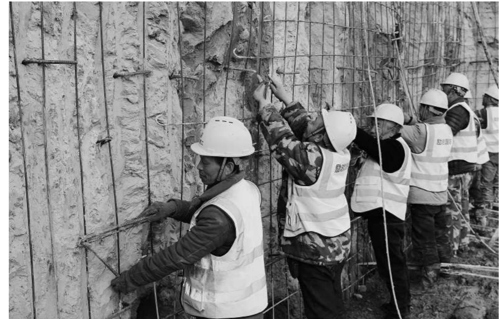
工人正在施工现场忙碌。
