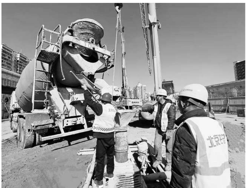
安立路快速化改造工程5标段施工现场。
