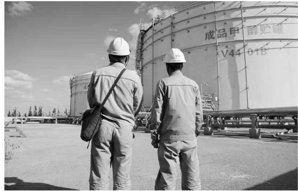
工作人员正在巡检罐区。
