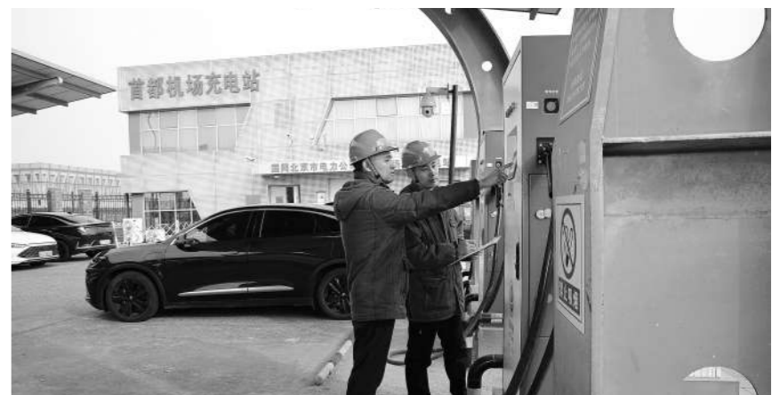
工作人员对首都机场充电桩进行巡查。
