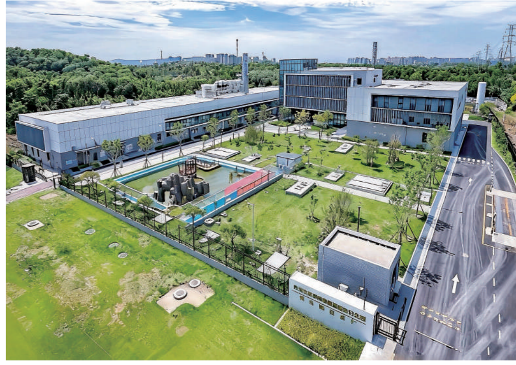
垡头再生水厂外景。
