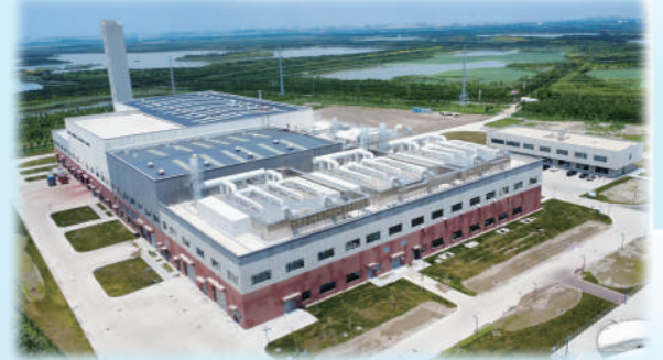
京城环保参与建设的天津市津沽污水厂三期污泥干化焚烧项目。
