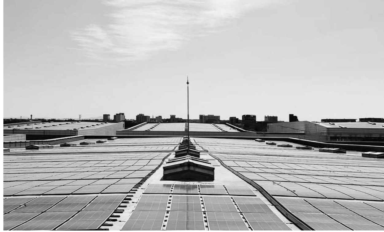
顺义国展低碳智慧能源升级改造项目。
