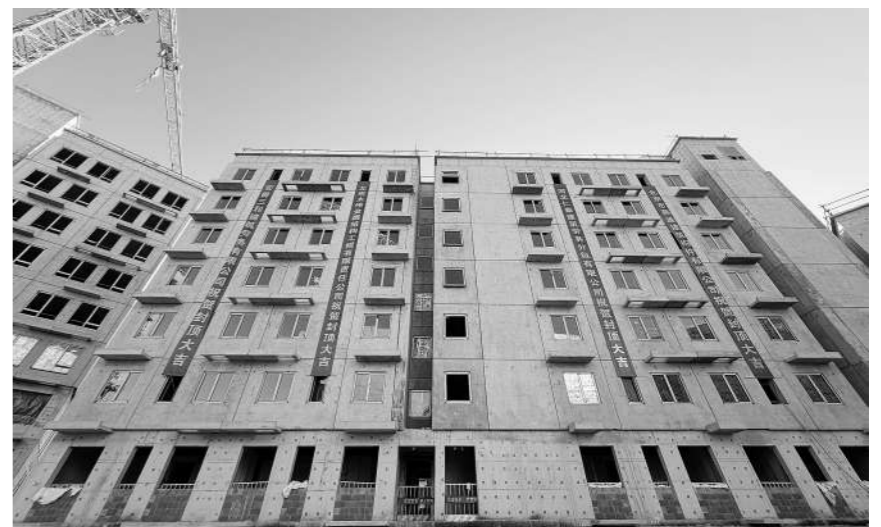
顺义区仁和镇河南村项目。
