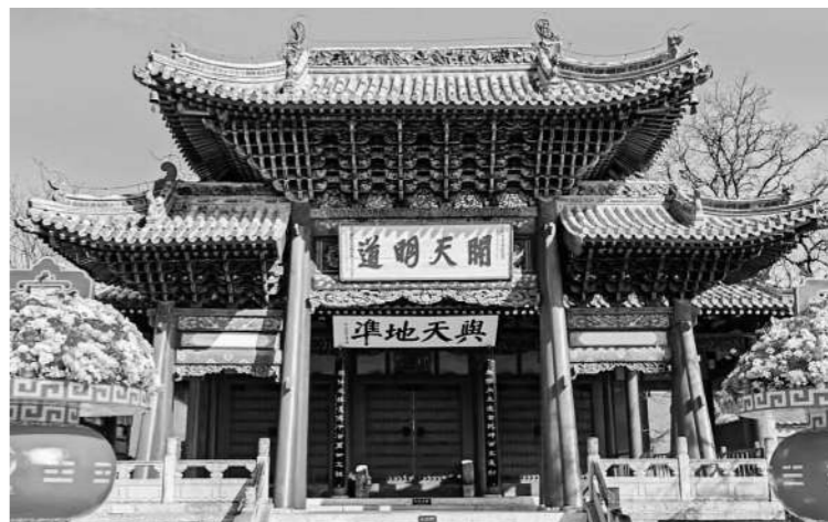
天水伏羲庙修缮后的外景。
