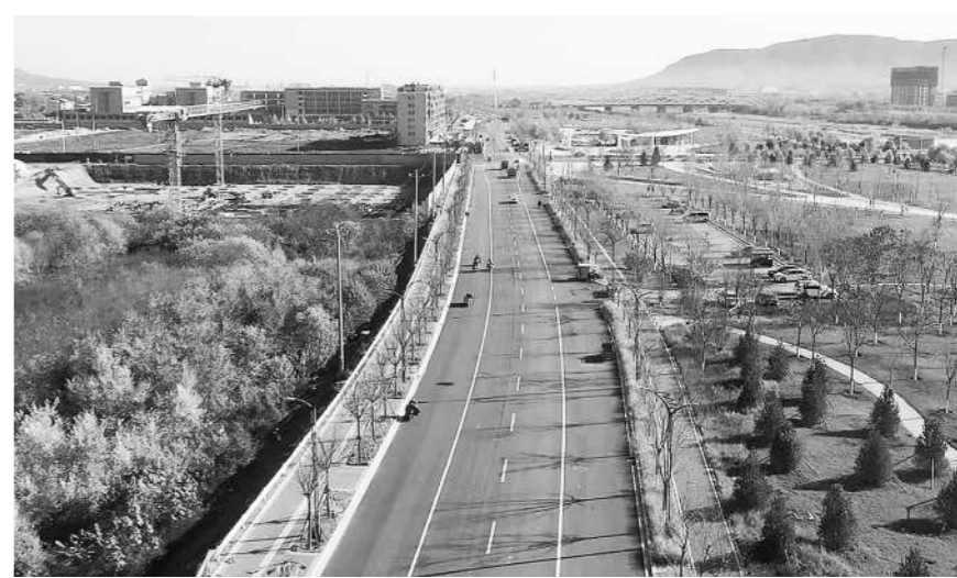
龙门片区市政基础设施一期建设项目道路工程通车。
