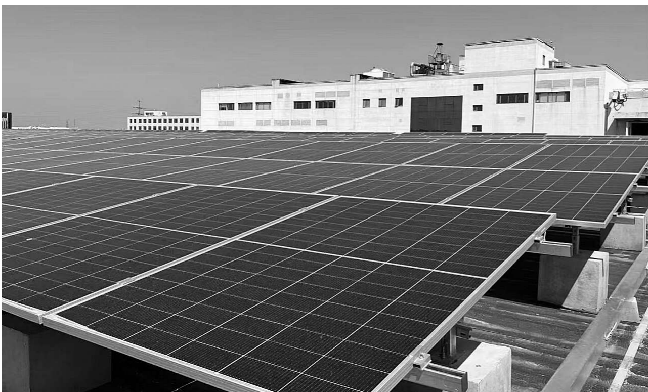
制药公司利用厂房楼顶空地安装了分布式光伏发电系统。
