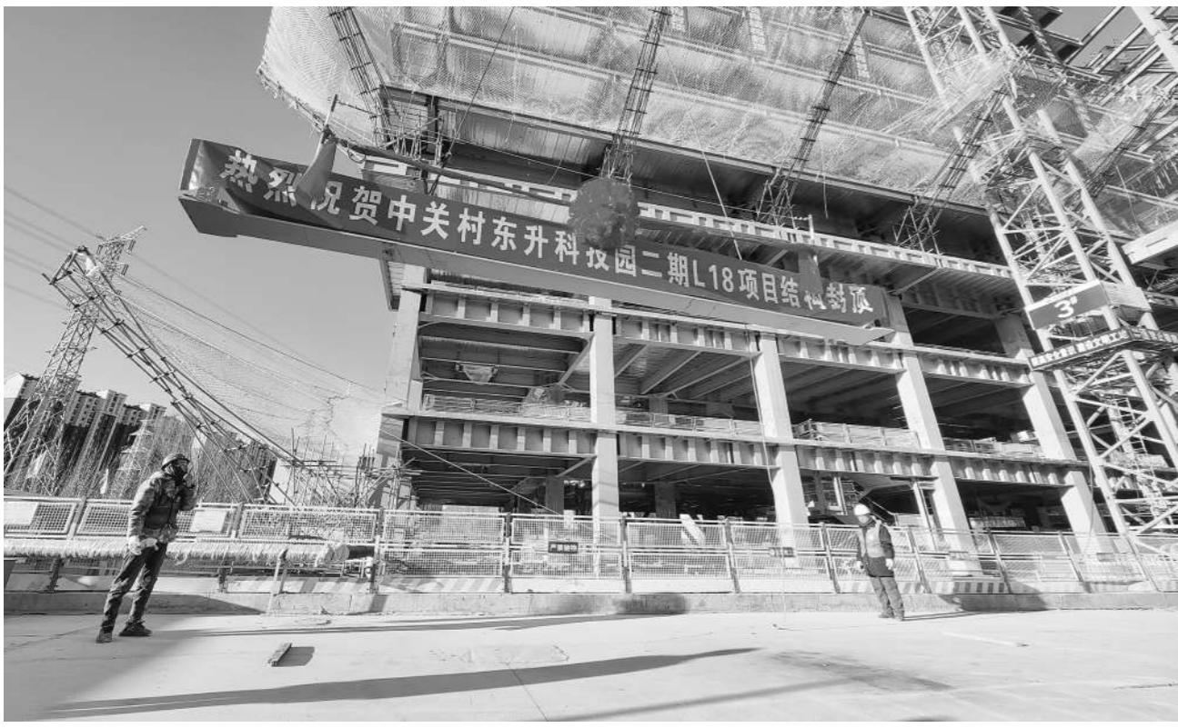
中关村东升科技园二期L18地块主体结构全面封顶。
