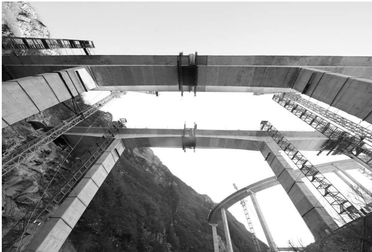
东庄子大桥成为全线首座刚构合龙的桥梁。
