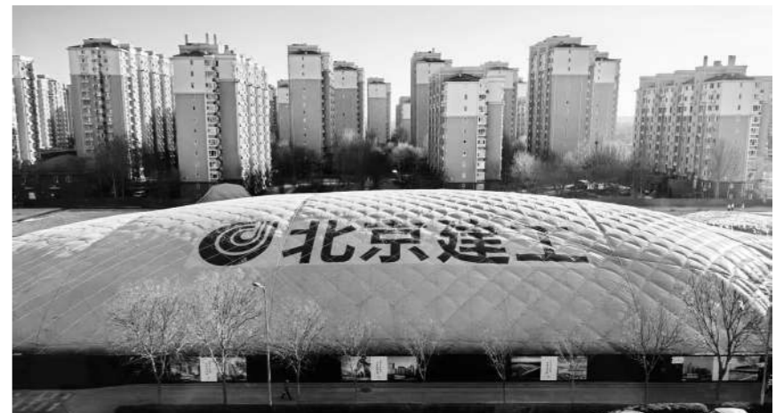
槐房村和新宫村旧村改造项目现场。
