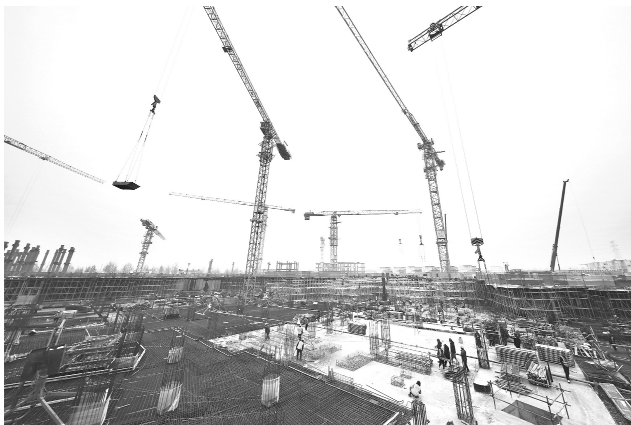
北京儿童医院新院区建设工程现场。
