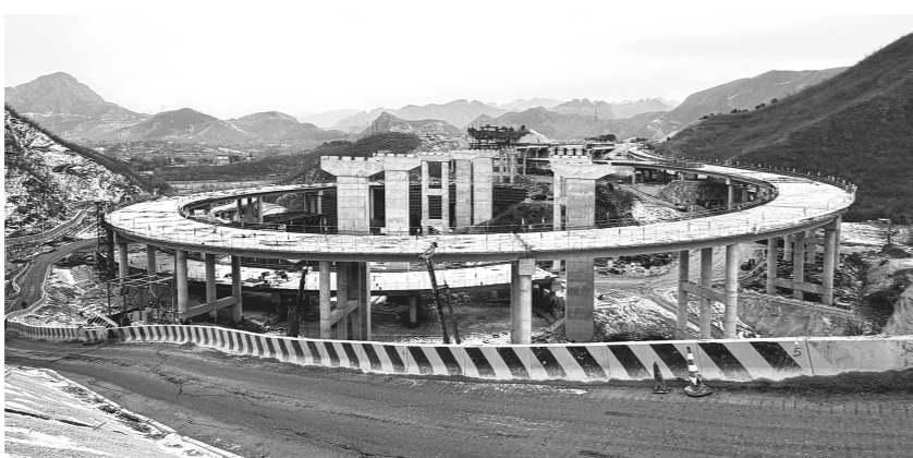
108新线高速公路工程施工第4标段现场。
