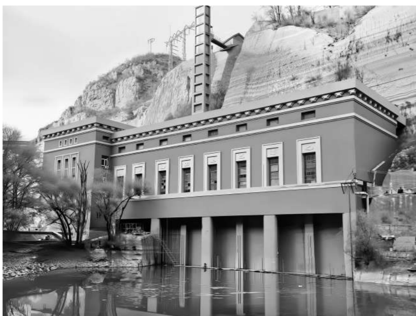
更新改造后的官厅水电站厂房。
