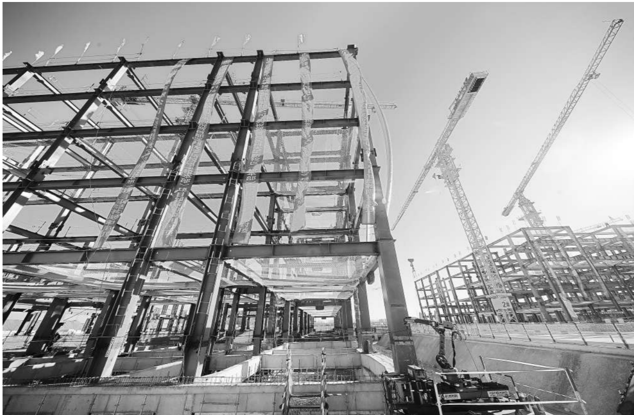
首都医科大学新校区南校区食堂主体钢结构封顶。
