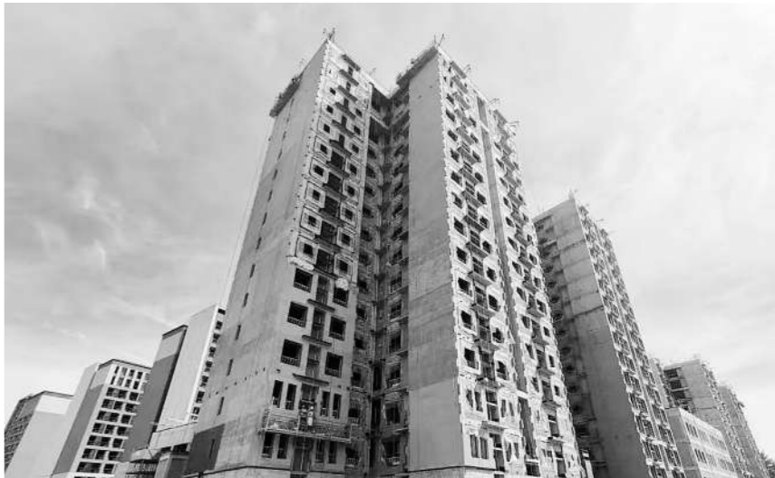
北京城市学院顺义校区三期建设工程(教师宿舍)项目现场。
