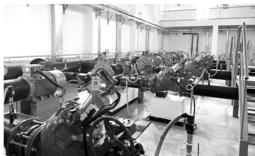
顺义区木林水厂建设工程现场。
