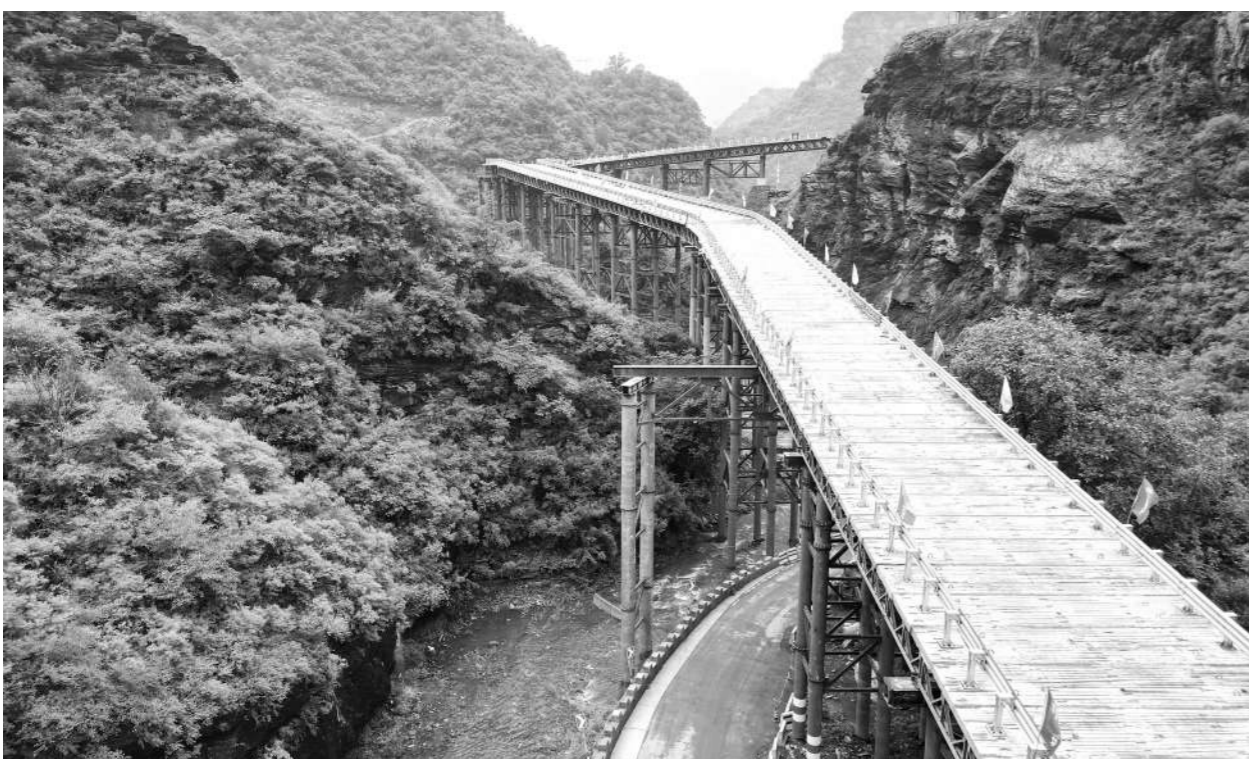
“咽喉工程”笛子港隧道进口钢栈桥全面贯通。
