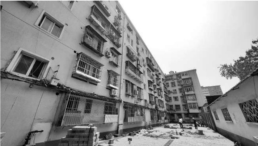
曙光西里小区老旧综合改造施工现场
