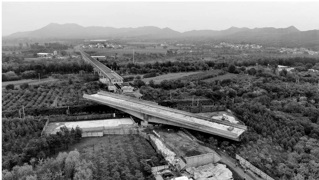
7000吨桥梁转体85度,打通南山环线三期最后一个关键节点
