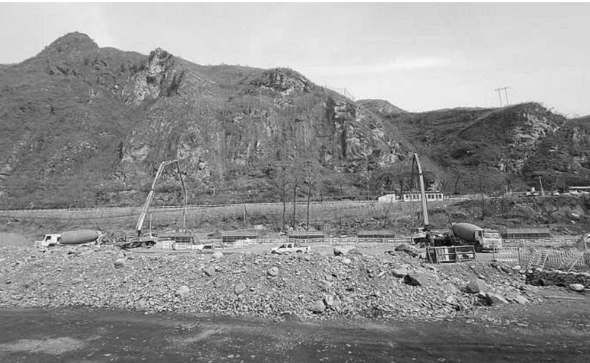
北京公司兴房站保供项目正在施工中
