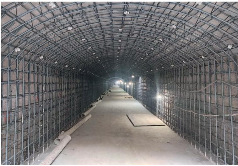
西黄村积水点治理工程暗挖隧道二衬钢筋绑扎场景
