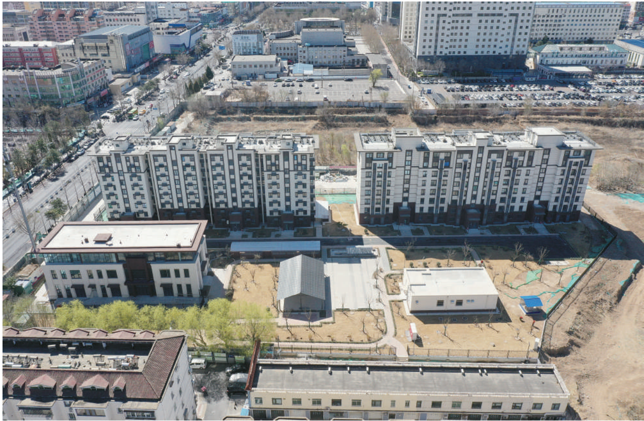
密云区鼓楼西区定向安置房现场
