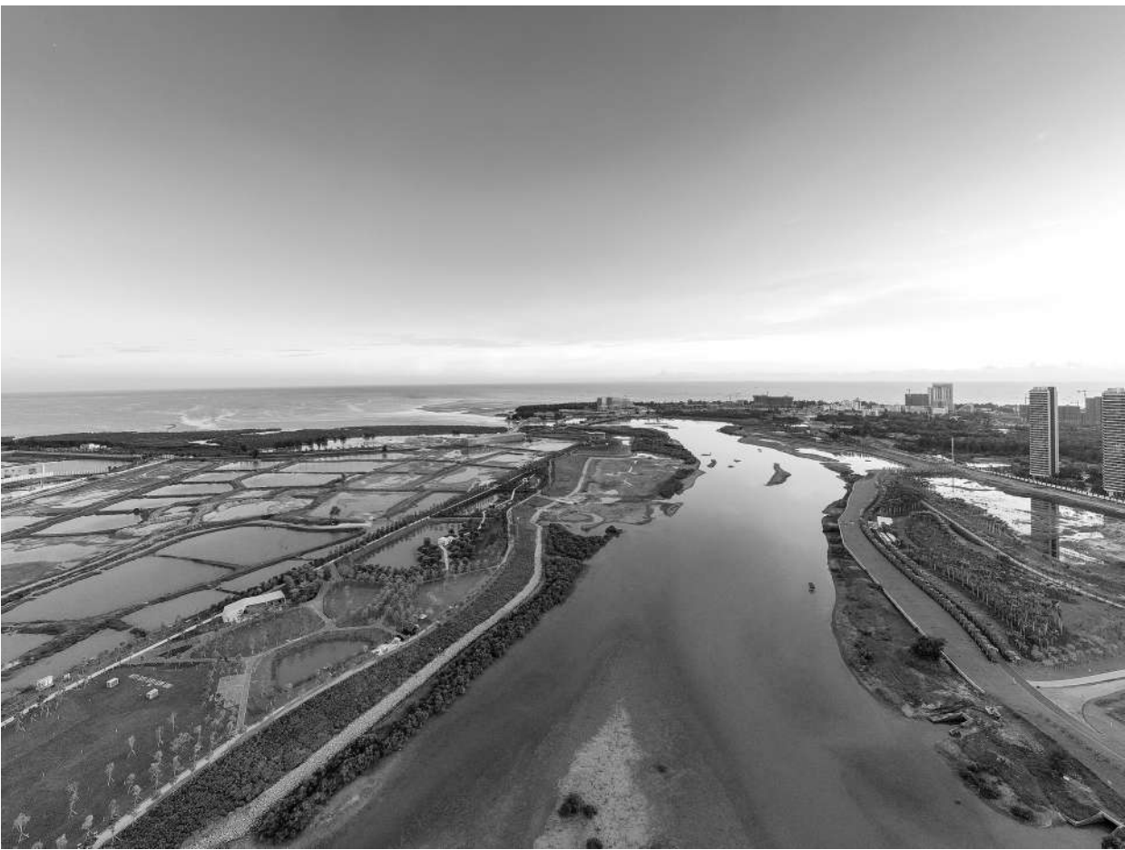
北海市滨海国家湿地公园(冯家江流域)水环境治理工程现场
