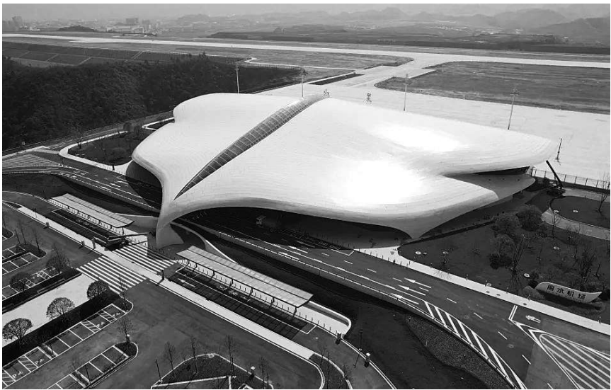
由建工集团施工的丽水机场项目通过竣工验收
