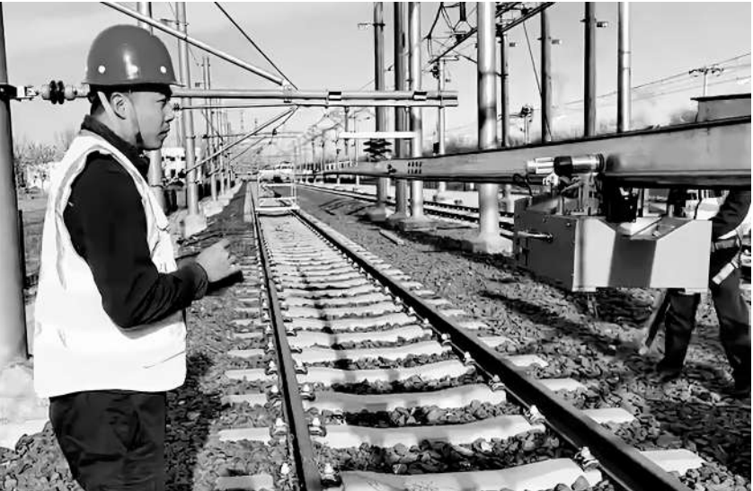
北京地铁供电专业技术人员使用自主研发装置检查接触网设备
