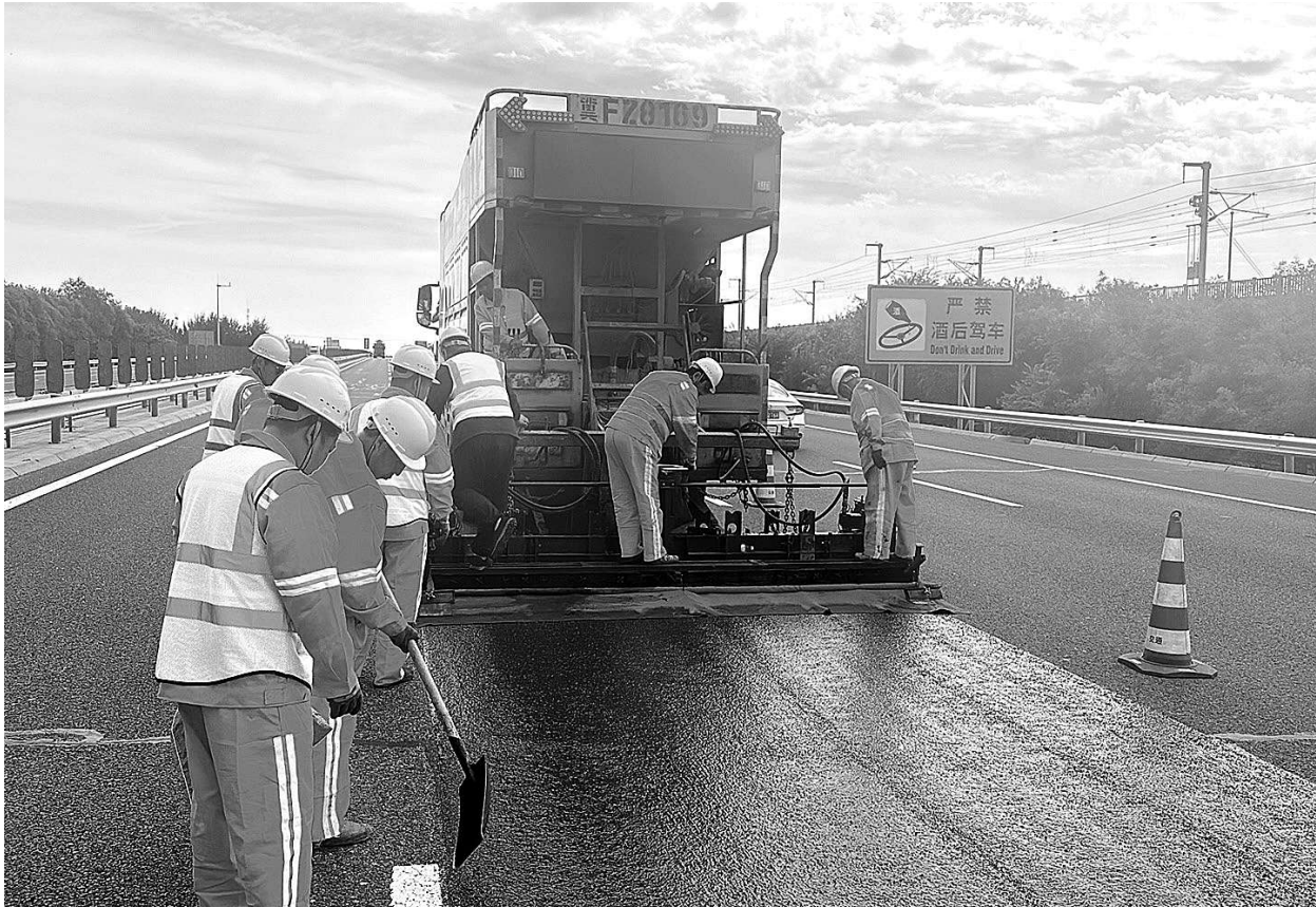
SBS超粘纤维薄层表处技术成功应用于京津高速公路
