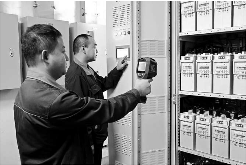
北京地铁应急电源柜更新改造工程竣工
