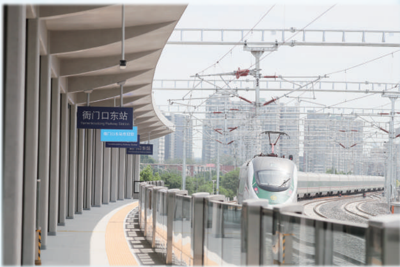
列车驶过衙门口东站。
