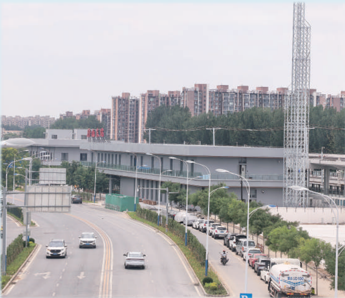
房山东站为副中心线西段提升工程新建车站。
