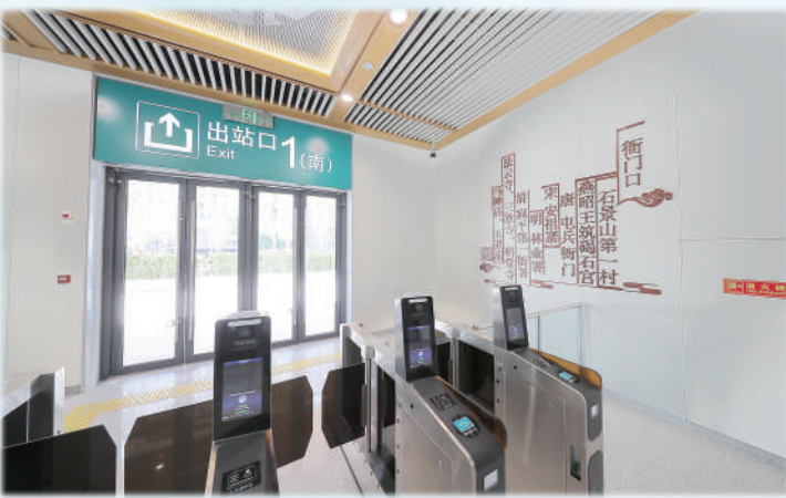
“副中心线西段提升工程”共设置61台融合检票闸机。
